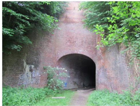
Tunnel onder de Bosstraat (R18)
