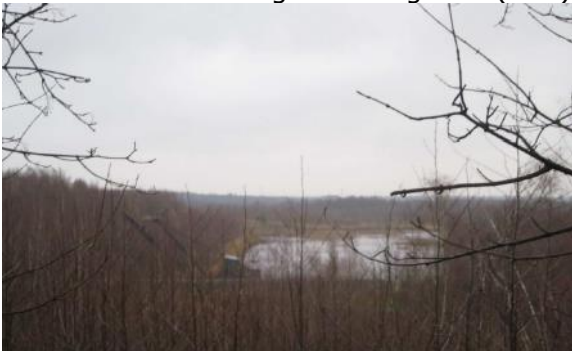
Bagger kleiput Nachtegaalstraat (R29)
