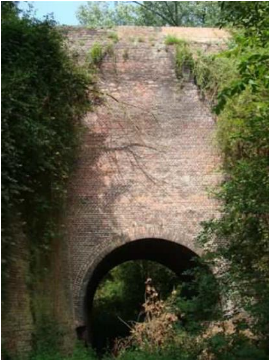
Tunnel onder verlengde Terhagenlei (R16)
